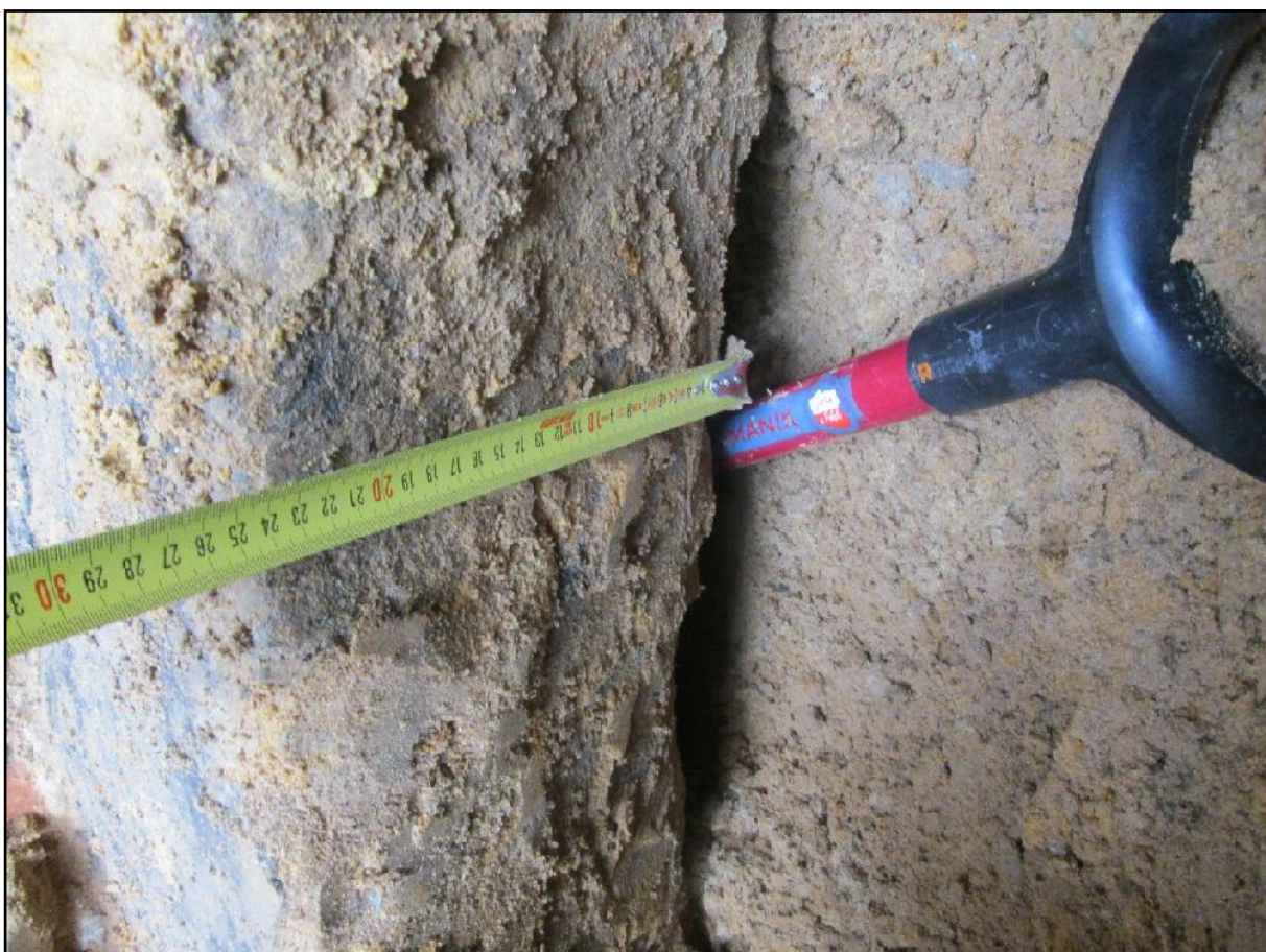
Odkrywka– ława fundamentowa
