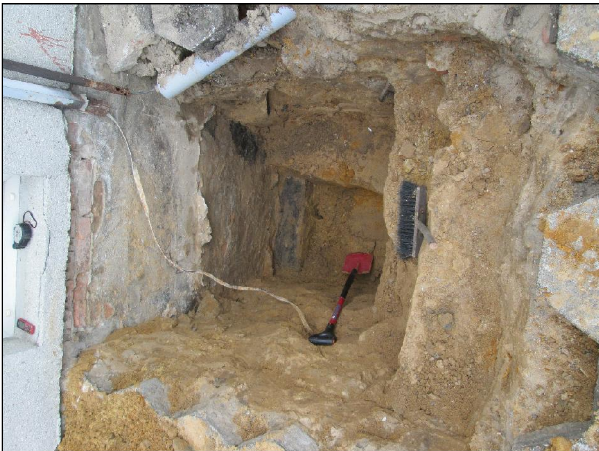
Odkrywka– ściana fundamentowa
